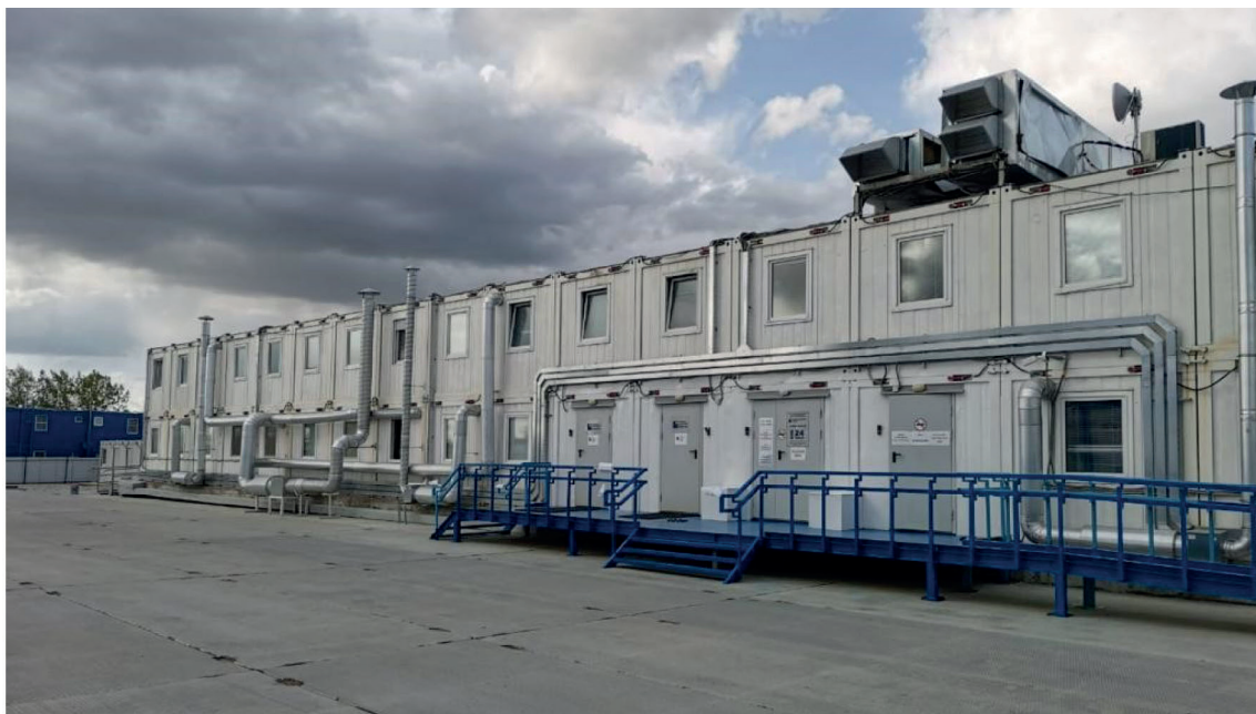
Рис. 1. Здание временного инфекционного госпиталя.
