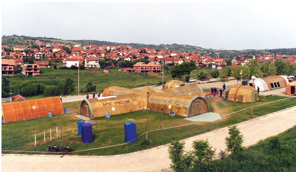
Рис. 1. Пневмокаркасная система модулей АМГ МЧС России.
