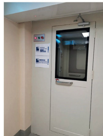
Вход в санитарный шлюз
